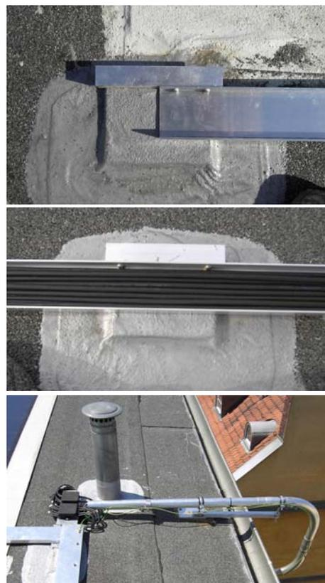
aufwendigen Handlings, können wir uns nun keinen besseren Träger und Langfristschutz für die PV-Module vorstellen. Selbst wenn die Dachhaut durch Erwärmung weich und wabblig wird, gegen Windangriffe und Überdehnungen dann ungeschützt, gibt das Blech als Träger dem PV-Plate den notwendigen Halt. Der Wärmeausdehnungskoeffizient von Modulkern und Träger ist gleich, was unter dem Aspekt der Langzeiteinwirkungen eine optimale Sicherheit darstellt.
